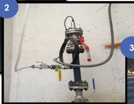
Toma de muestra desde la tubería
